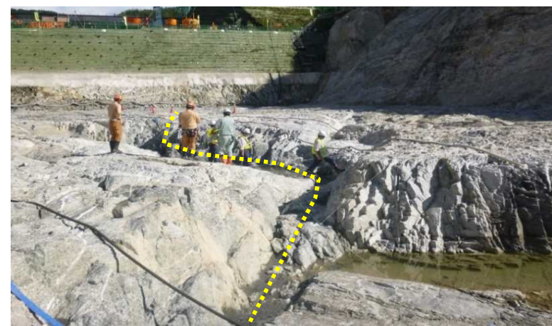
F-5断層(掘削後)
