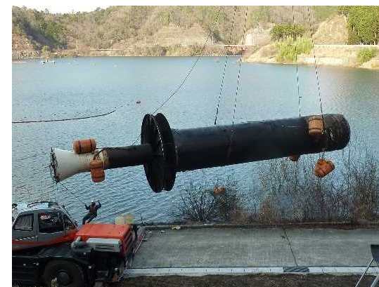
深層曝気設備イメージ(比奈知ダム)
