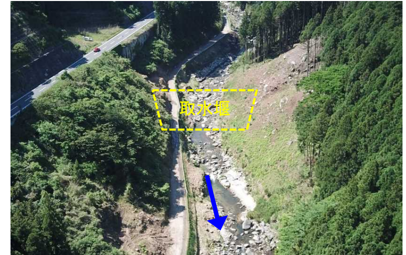
取水堰付近状況
