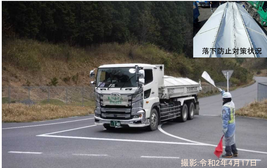
骨材の運搬状況
