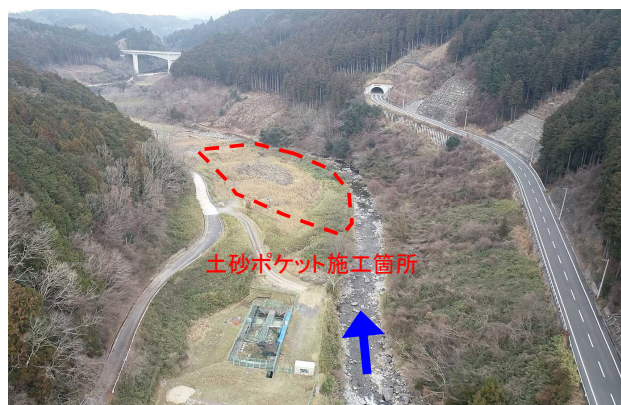
土砂採取地整備工事(現地状況)
