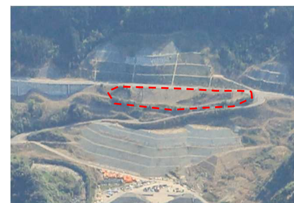
貯水池周辺整備工事(上川原)(現地状況)
