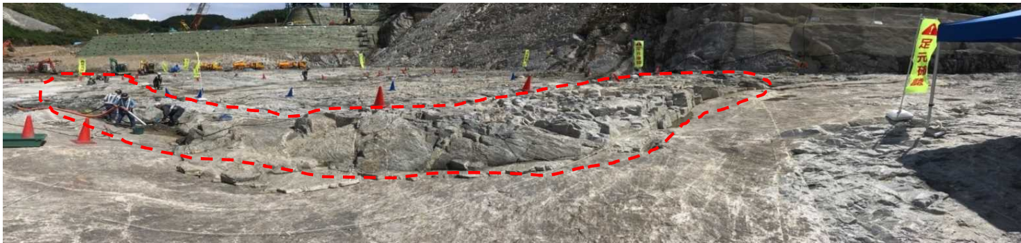
低角度割れ目(掘削前)
