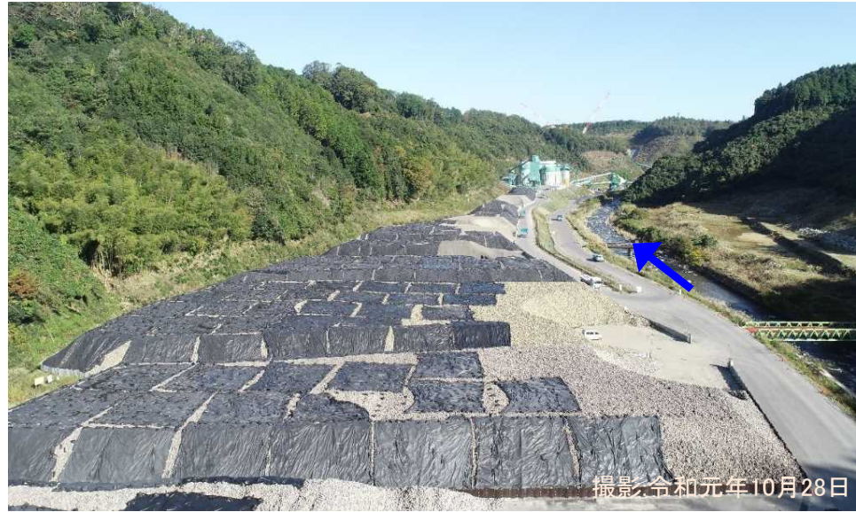
骨材の仮置き状況
