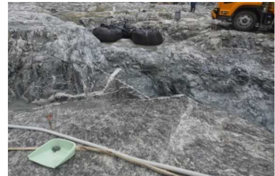
低角度割れ目 掘削後
