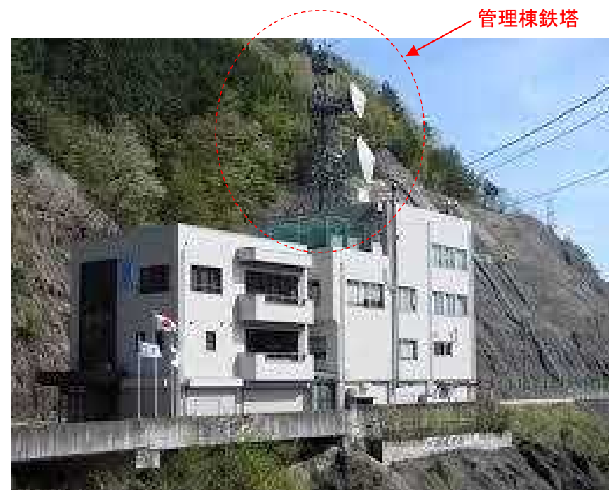
岩屋ダム管理棟鉄塔(イメージ)
