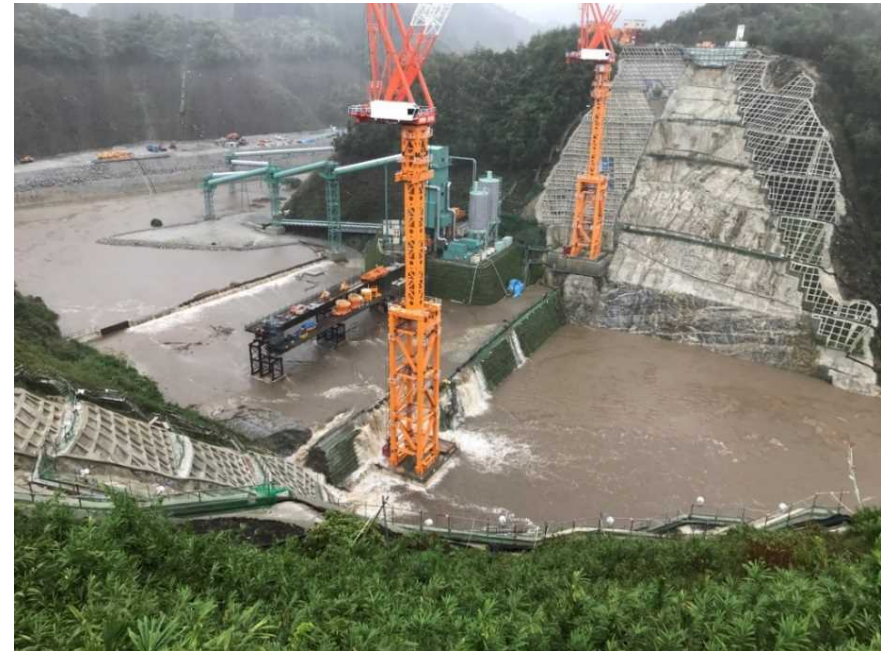
台風19号に伴う越流状況(Qmax=286m 3 /s)
