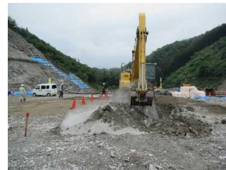
セメント安定処理 施工状況
