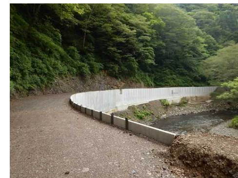
プレキャストL型擁壁施工状況 (12.0k付近)
