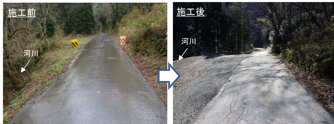
令和2年度 道路復旧状況(鷺見地区)
