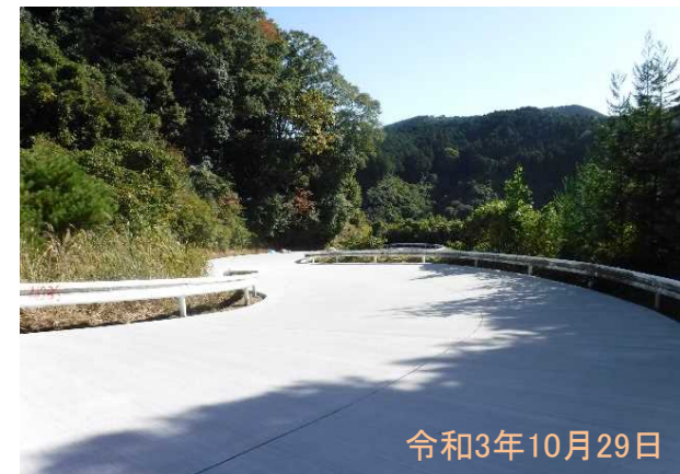
工事用道路施工状況
