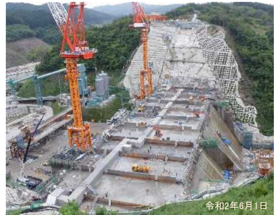
プレキャスト部材設置状況(通廊)
