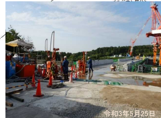
コンソリデーショングラウチング施工状況
