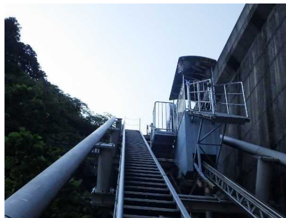
係船設備イメージ(大山ダム)
