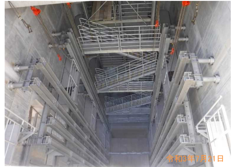
点検歩廊設置状況
