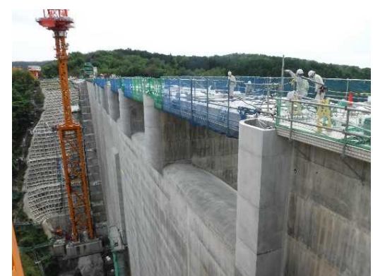
柱台橋脚(上流)
