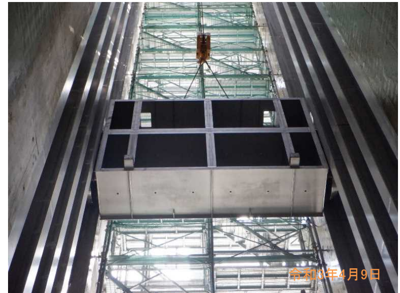
選択取水ゲート設置状況(取水塔内)
