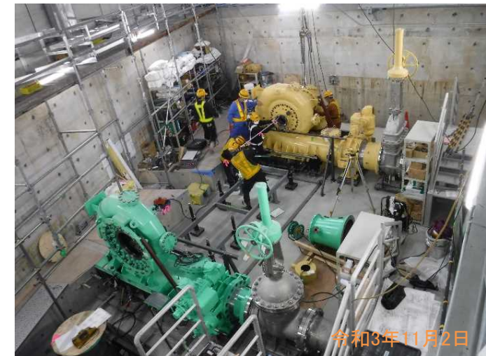
水車据付状況
