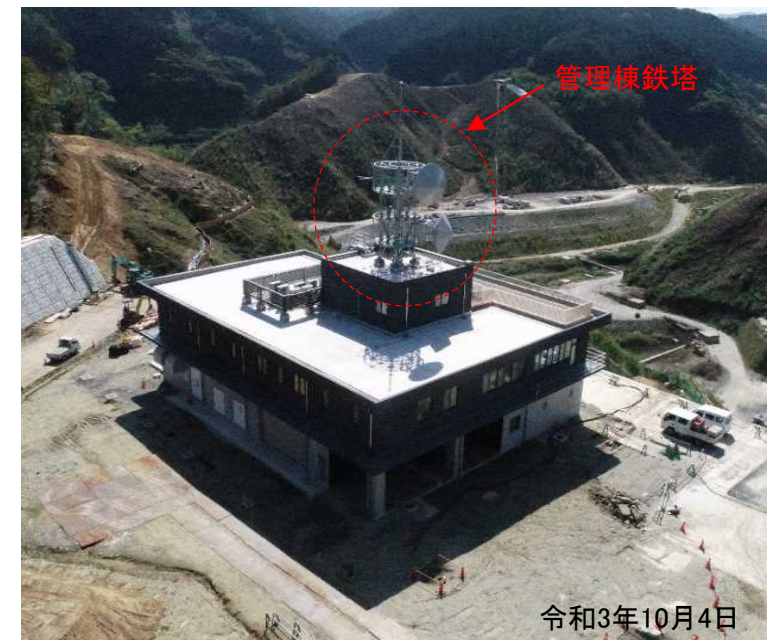
管理棟鉄塔設置状況
