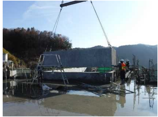
取水設備(取水塔側面部設置状況)
