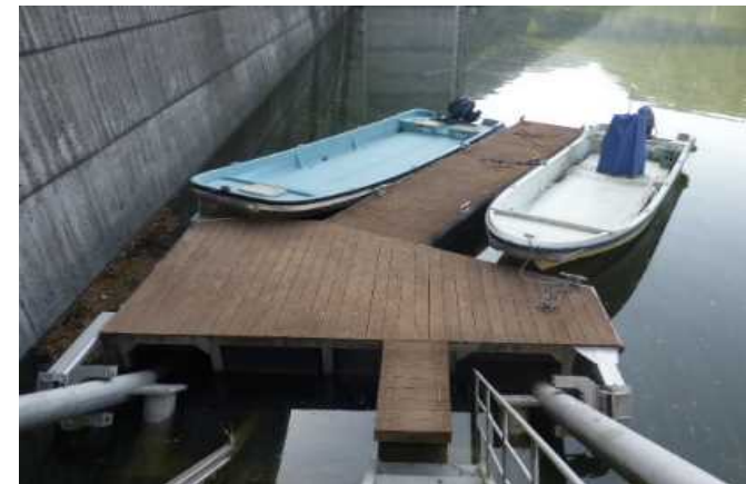
係船設備イメージ(大山ダム)
