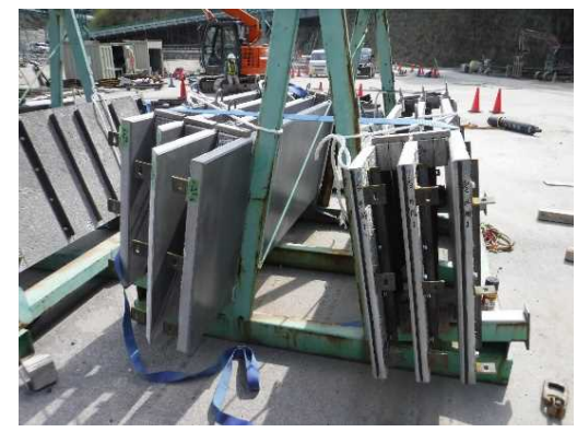
プレキャスト部材仮置状況
