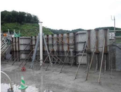
常用洪水吐き上流面(設置状況)
