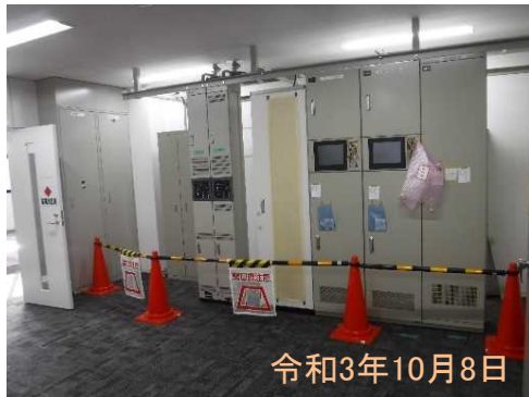
多重無線設備
