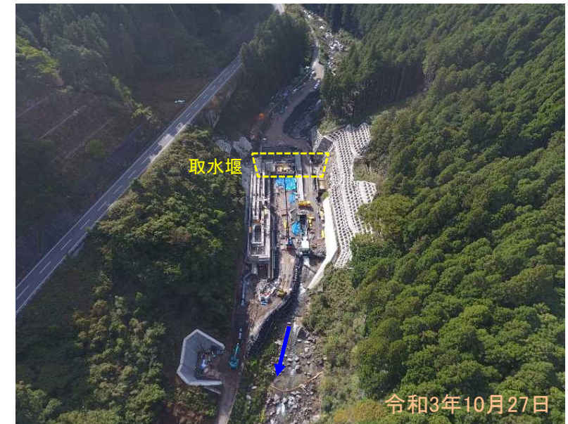
取水堰付近状況
