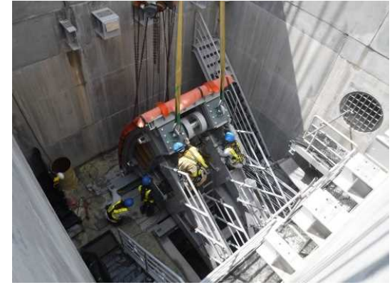
常用洪水吐き(開閉操作室)
