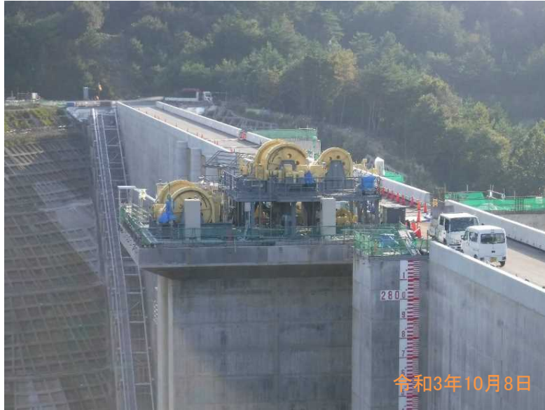
選択取水ゲート巻上機据付状況
