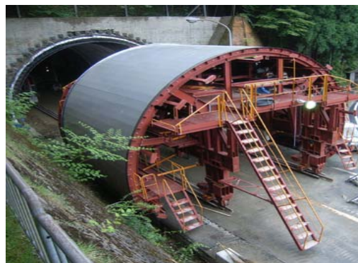
▲一般的な道路トンネル用スライドセントル
