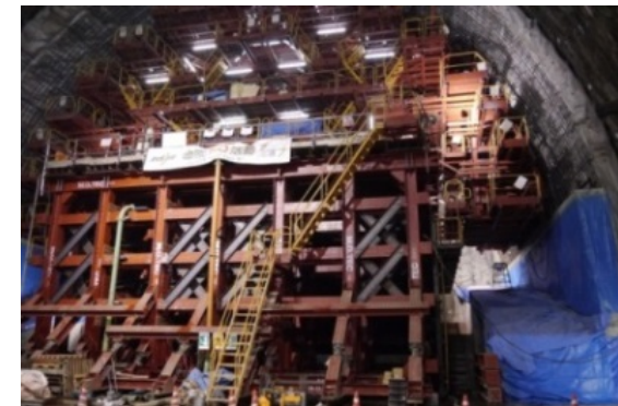
▲シュート部で使用したスライドセントル②
