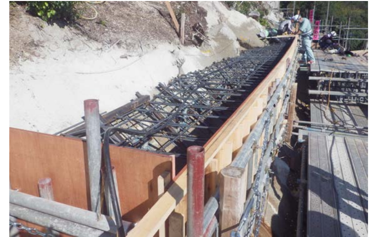
アンカー上部に鉄筋Coを施工し、ルートパイル 基礎部分を構築。
