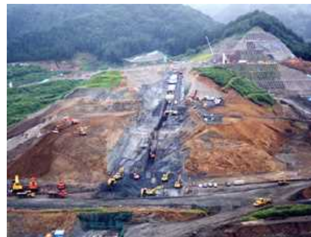
基礎掘削（他ダム事例）
