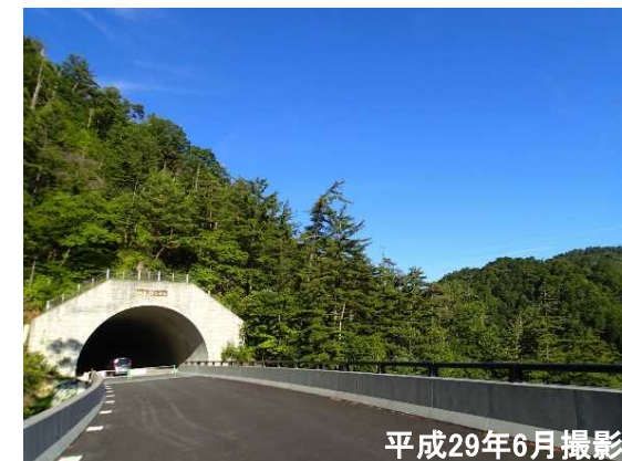
付替県道大津信楽線 桐生辻トンネルと新8号橋
