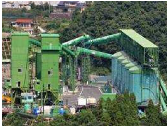
コンクリート設備全体写真（他ダム事例）
