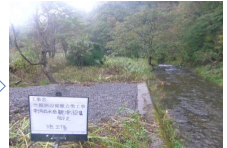
【中河内(水位観測所)撤去後】
