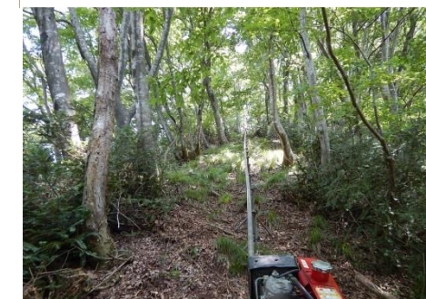
モノレール(立坑閉塞)
