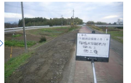
【福橋(水位観測所)撤去後】
