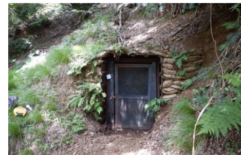
ダムサイト横坑(右岸NO.4坑)
