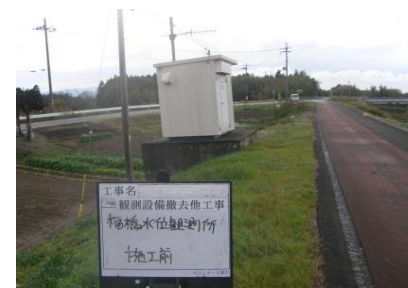
【福橋(水位観測所)撤去前】
