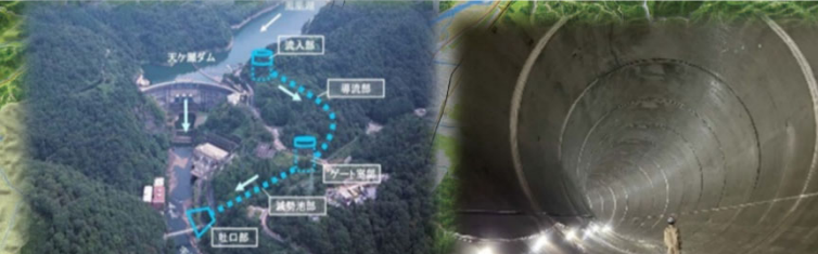
天ヶ瀬ダム再開発事業 (R5年3月完成) トンネル式放流設備
