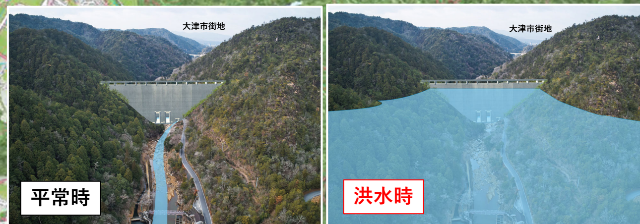
②ダム裏面（上流から下流方面）
