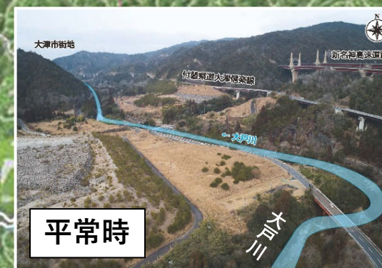
④ダム湖左岸側から（下流方面へ）
