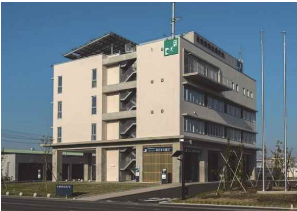
▲ 津波発生時の災害応急対策活動と津波避難ビルの機能を確保した石巻港湾合同庁舎
