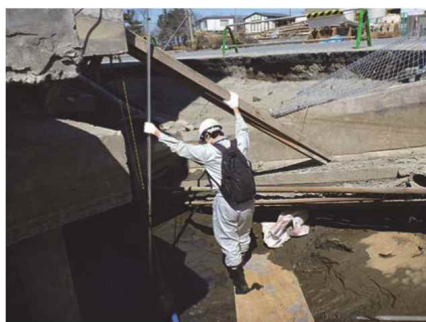
▲ 官庁施設の被災状況調査
