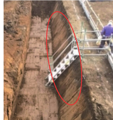
IoT建築土工を活用した施工
