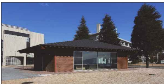
海上保安大学校国際交流センター国際講義棟
