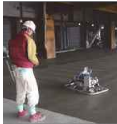
施工合理化技術の導入促進(ex.コンクリート床仕上げロボット)
