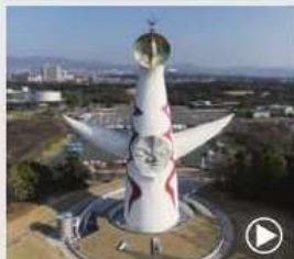
大阪府 リバース太陽の塔再生 太陽の塔内部の改修映像
