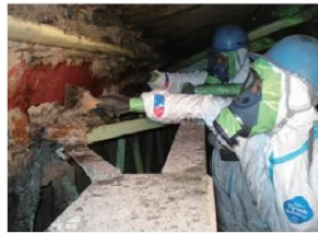
アスベスト撤去作業
