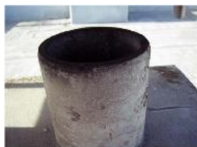
煙突用石綿断熱材
