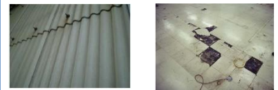
石綿スレート Pタイル床材
