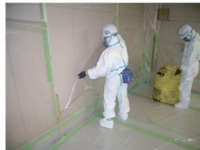
隔離養生作業
