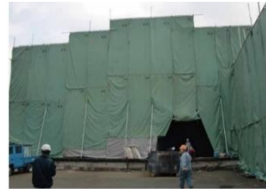
建物全体を隔離
