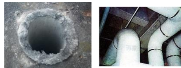
石綿円筒管 保温材
