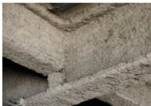
鉄骨の吹付耐火被覆材
