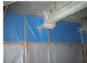
作業エリアを隔離
