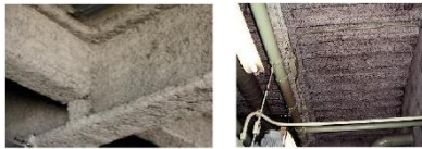
鉄骨の吹付耐火被覆材 天井材 ロックウール
