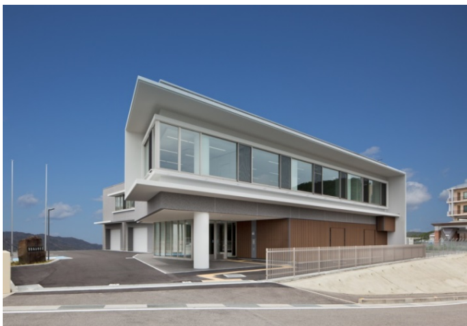
庁舎 正面外観
