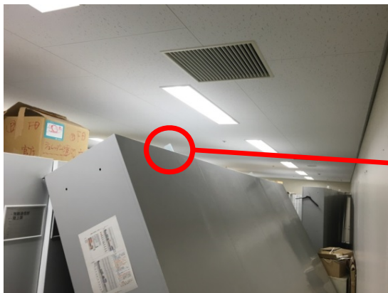
キャビネットの転倒事例③-1 (石こうボード壁固定・床非固定)
