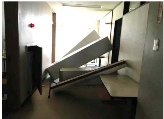
キャビネットの転倒事例② (床・壁非固定)
