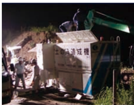
土のう造成作業による緊急水防対策 (奈良県大和郡山市)
