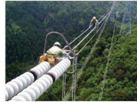
〈送電線の点検作業〉
