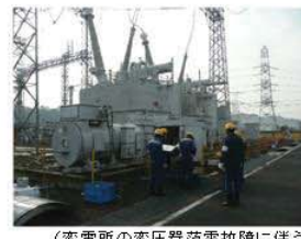
〈変電所の変圧器落雷故障に伴う復旧修理後の確認試験〉
