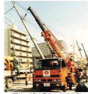
〈阪神・淡路大震災での建柱作業〉
