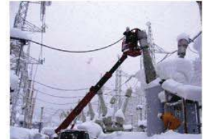
〈変電所の架線復旧作業〉
