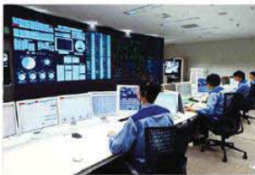
〈停電復旧訓練の様子〉
