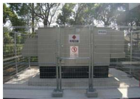
<休憩施設の自家発電設備整備>
