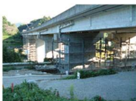
<耐震補強工事の推進>
