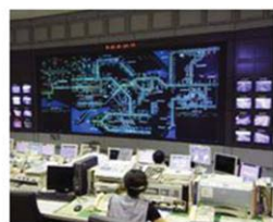
<情報拠点(道路管制センター)>
