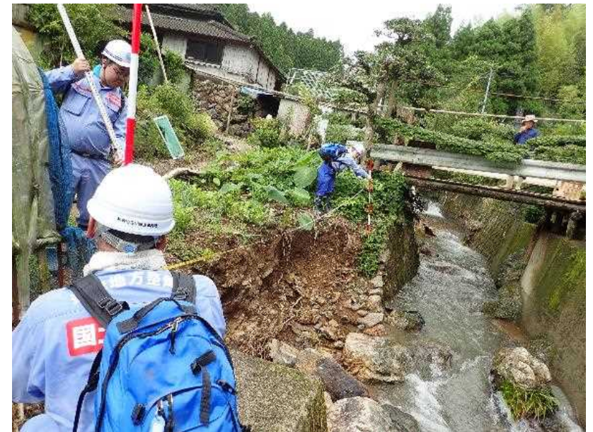
7/25【河川班】被害状況調査(芦北町)
