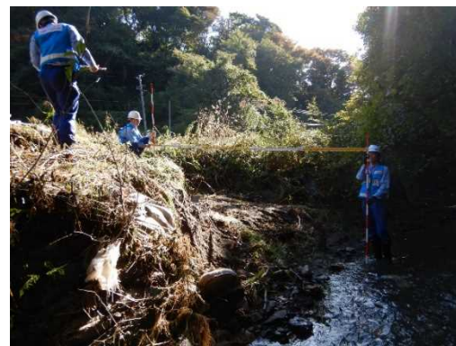
■10/23 河川被災状況調査 (宮城県大郷町)
