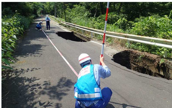
■ 現地調査状況（西米良村板谷地先）
