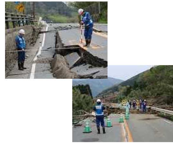
県道339号(ミルクロード)の被災箇所調査
