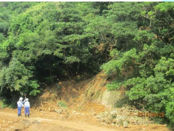
被災箇所の調査(道路)
