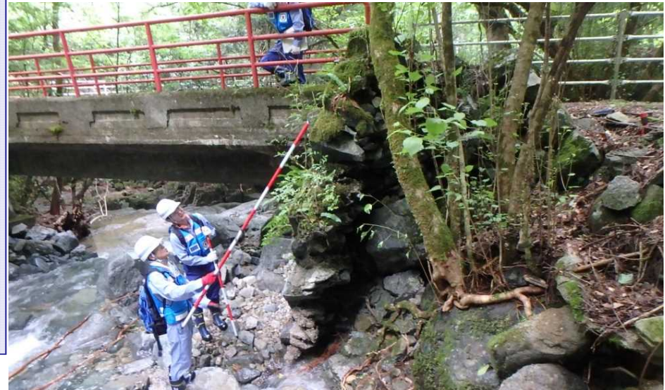
7/11 宮津市内での被災調査状況
