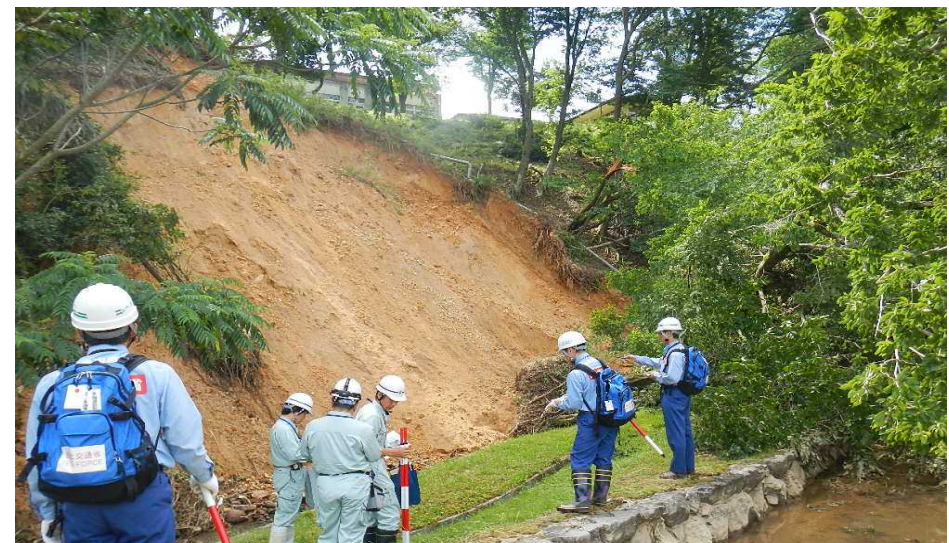
7/11 福知山市内での被災調査状況
