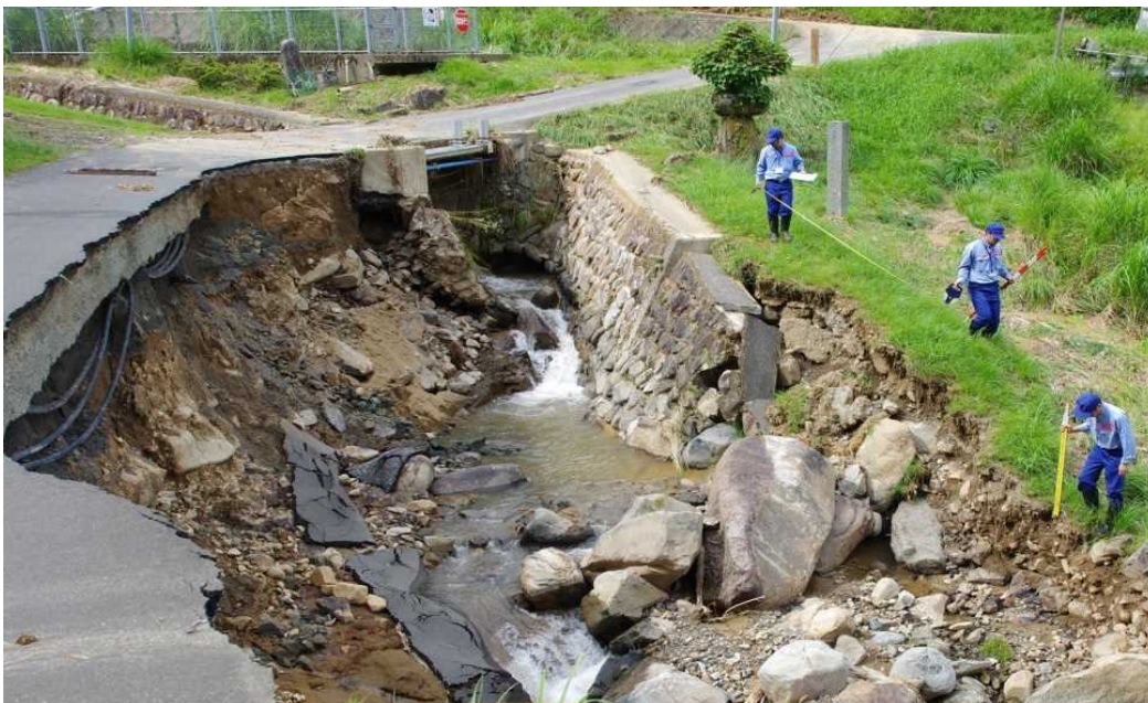
7/11 福知山市内での被災調査状況
