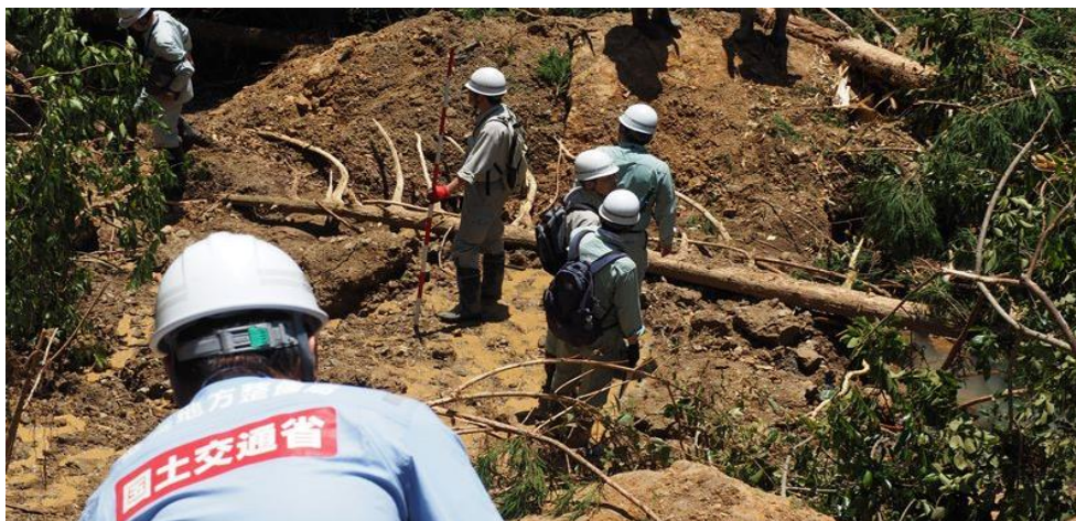
7/10 土砂崩れによる天然ダムの現地調査を実施
