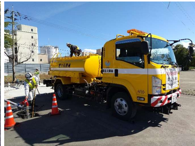
【給水班】金沢市 補水状況（18日）
