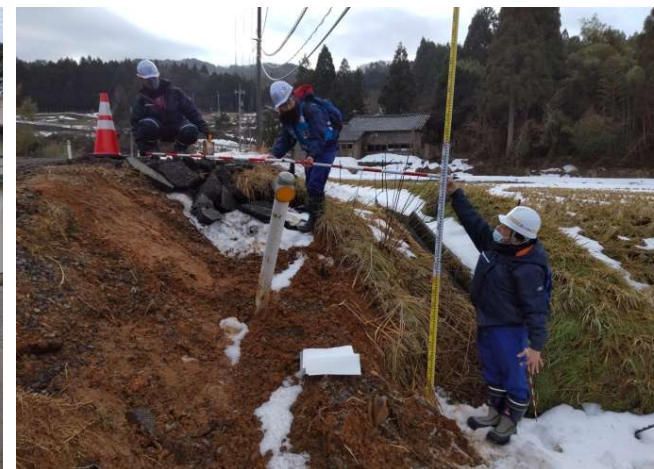
【市道調査班】珠洲市 作業状況（19日）
