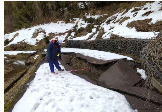
【砂防班】珠洲市 作業状況（19日）
