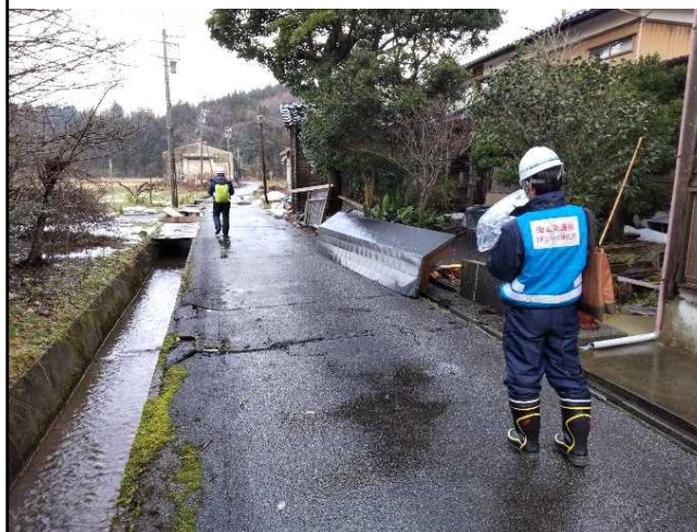
【営繕支援班】珠洲市 応急危険度判定作業状況(12日)
