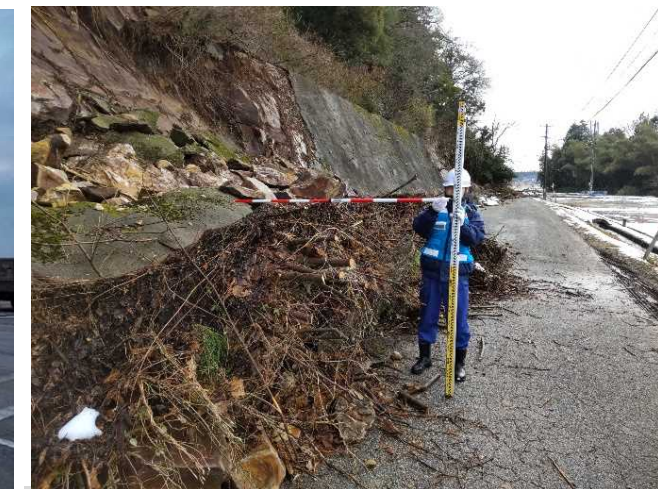
【市町道調査班】珠洲市 作業状況(11日)
