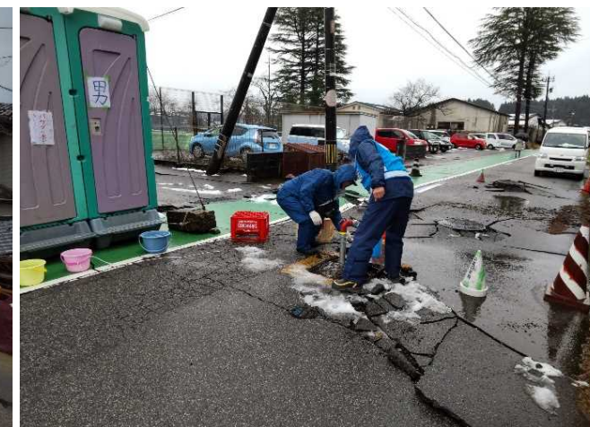
【高度技術指導班(水道)】穴水町 日本水道協会による漏水確認作業に同行 (10日)
