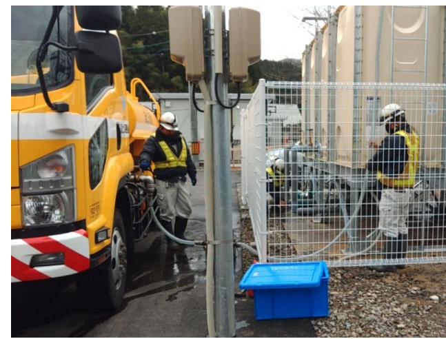
【給水班】輪島市 給水作業（28日）
