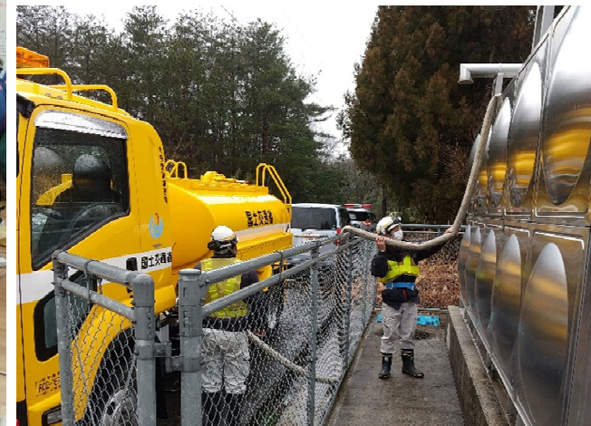
【給水班】能登町 給水状況（21日）
