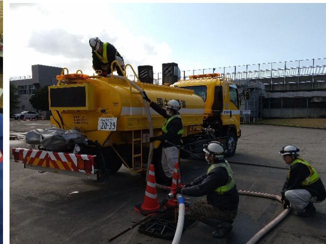
【給水班】金沢市 補水状況（12日）
