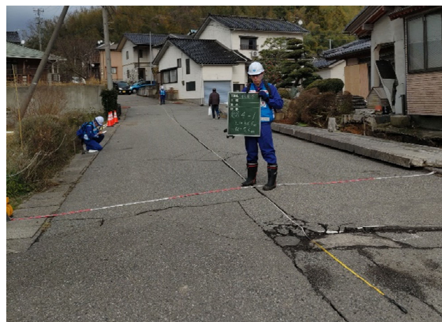
【道路班】輪島市 被災状況調査（6日）
