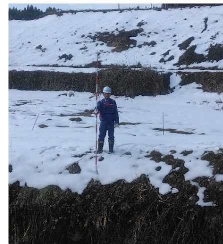
【河川班】輪島市 作業状況（31日）
