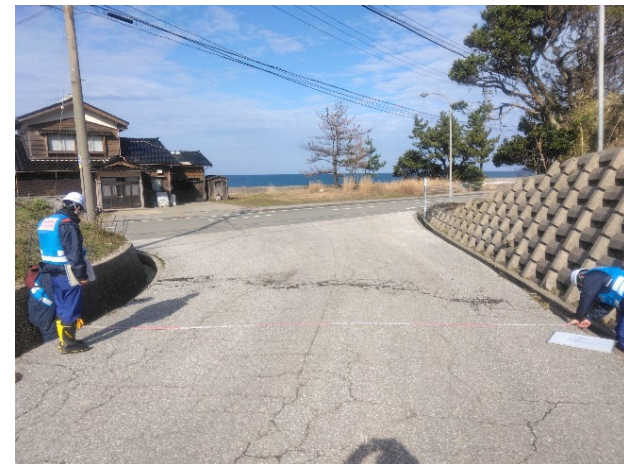
【道路班】珠洲市 作業状況（31日）
