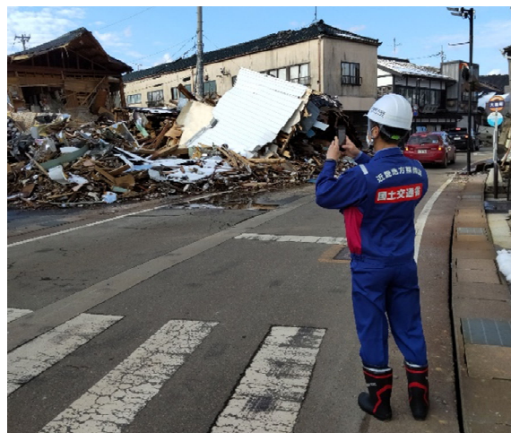
【水道班】穴水町 作業状況（31日）
