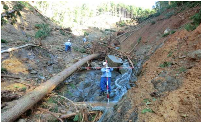
砂防班による被災調査 (忠野地区)
