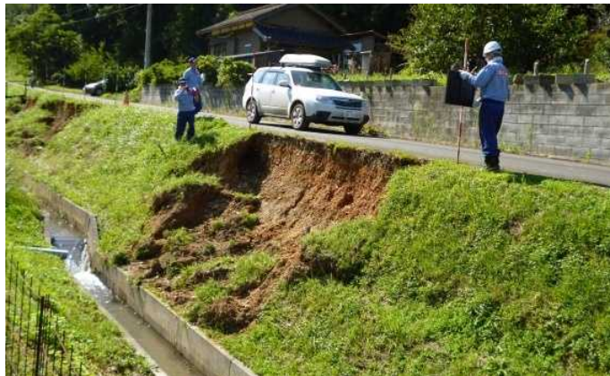
道路法面被災箇所の調査
