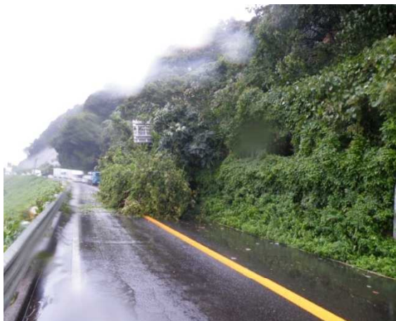
被災状況(9月16日 8:00撮影)
