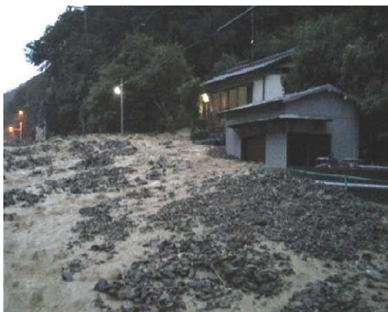
被災状況(9月16日 5:00撮影)
