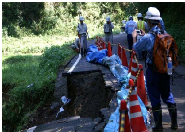
道路の被災状況調査(舞鶴市白滝地区)
