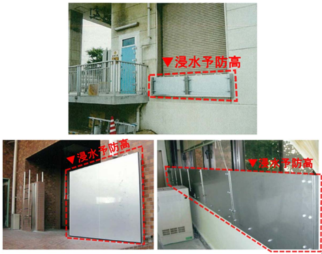
図1 ポンプ施設対策化の事例
