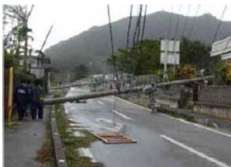
写真 3.2.1 台風による電柱の倒壊
