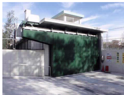
図3 泉尾配水場の防潮扉
