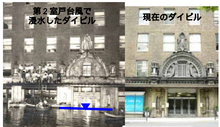
写真 2.2.6 ダイビルの浸水状況
