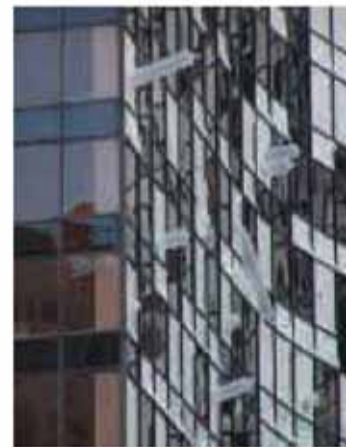
ハリケーン・カトリーナによる高層ビルの窓ガラスの破損
