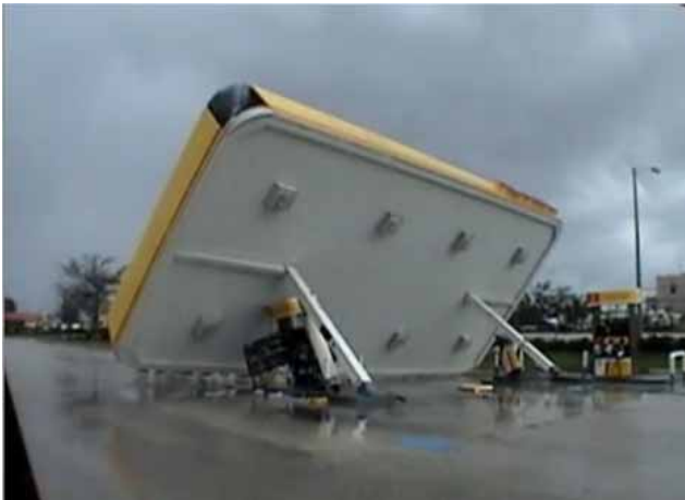
構造物の倒壊
