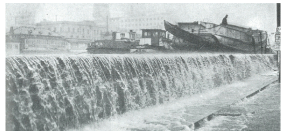
写真 2.2.5 堂島川の被害(大阪市)
