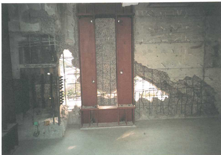
写真-28 神戸第2地方合同庁舎の復旧状況
