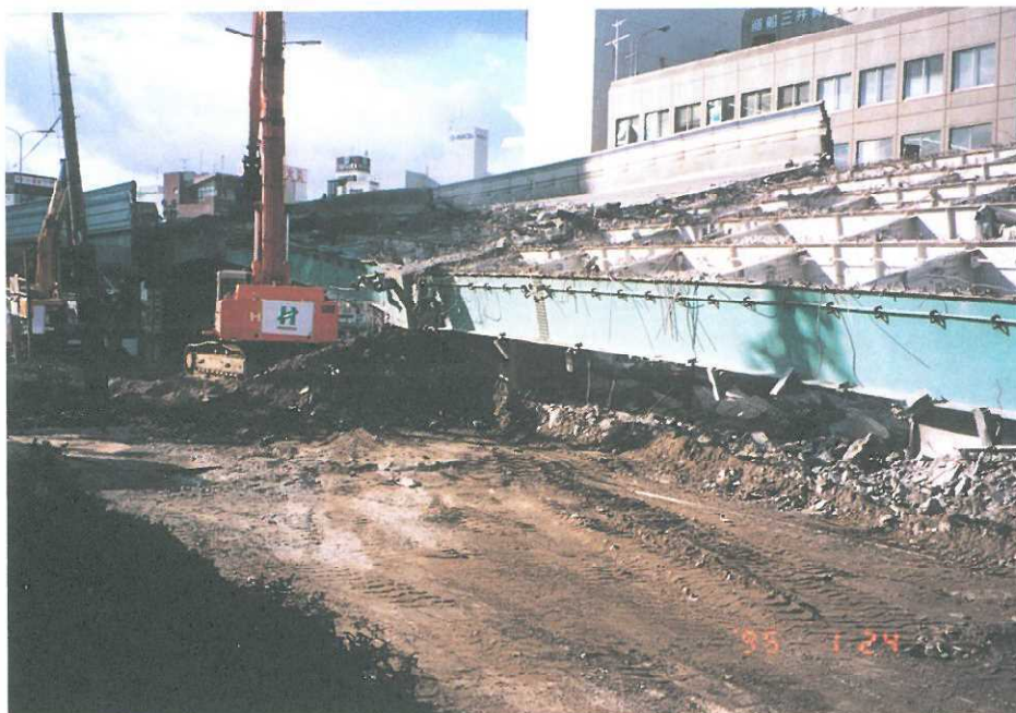
写真-12 国道43号岩屋高架橋の撤去状況
