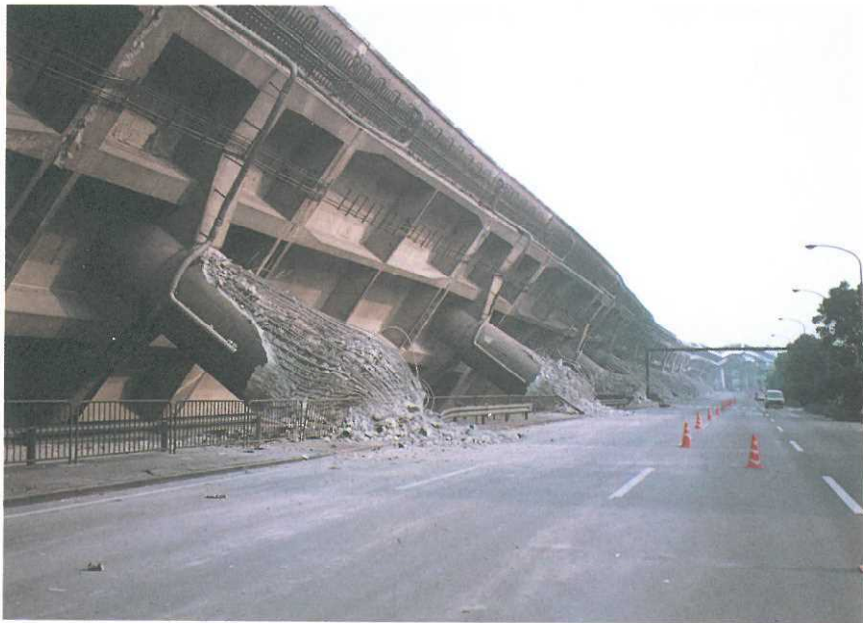
写真－7 阪神高速神戸線の高架橋の倒壊（神戸市東灘区深江地区）
