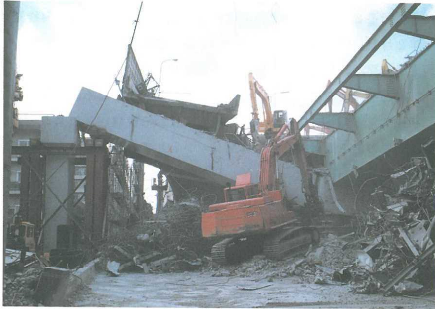
写真－ 8 阪神高速神戸線川東地区の撤去状況
