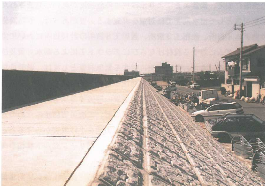
写真-22 東播海岸（明石市大観町地先）の完成写真
