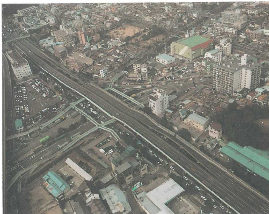
写真-4 国道43号岩屋高架橋の倒壊現場
