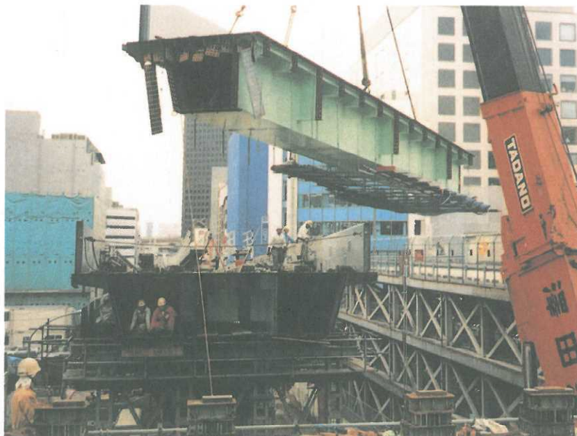
写真-14 国道2号ポータルライナー復旧状況
