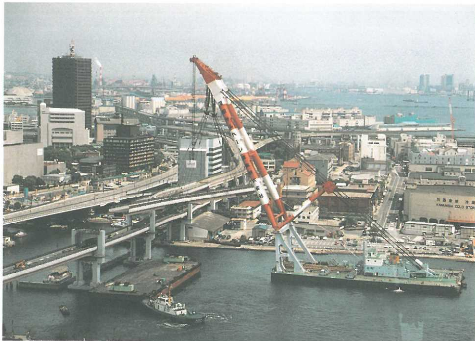
写真-13 国道2号浜手バイパス復旧状況
