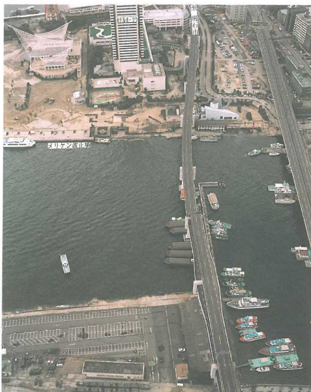
写真 3 国道2号浜手バイパスの損傷状況
