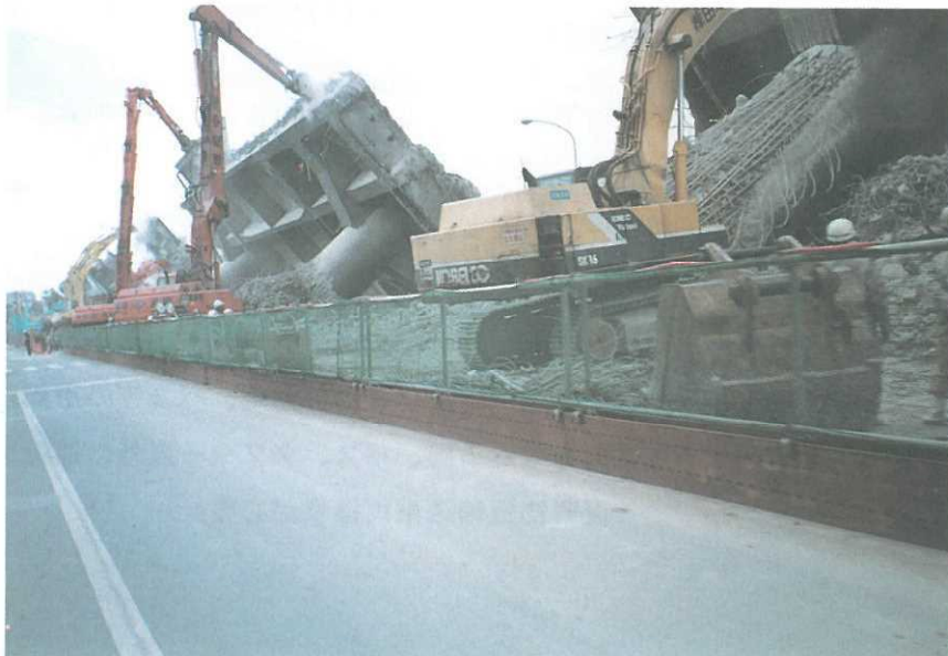
写真－ 9 阪神高速神戸線深江地区の撤去状況
