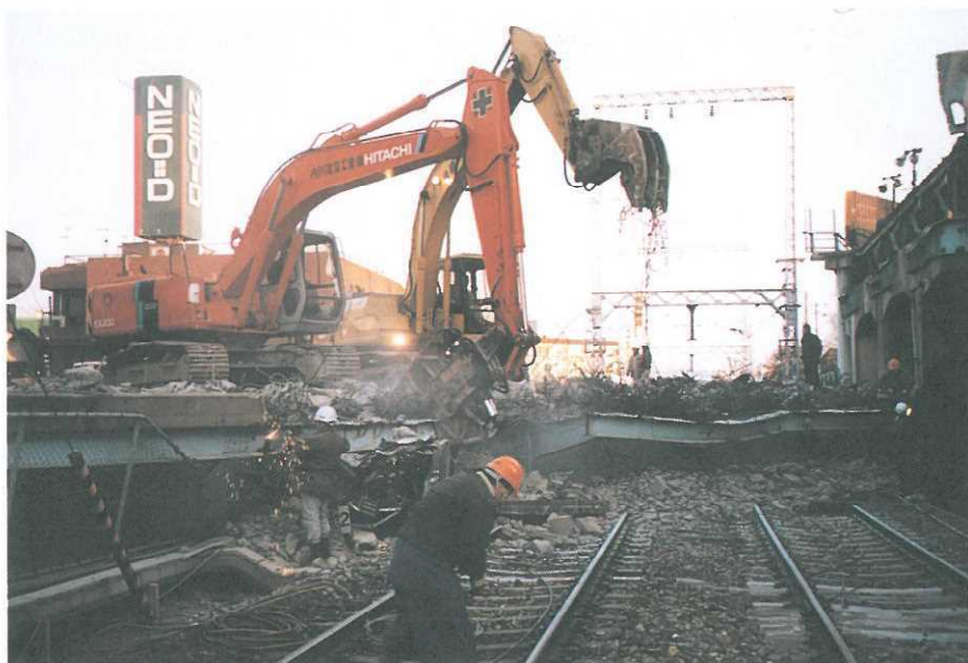
写真-15 国道171号門戸高架橋の撤去状況
