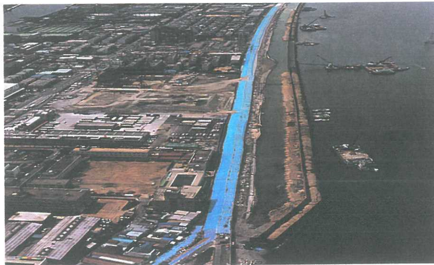
写真-18 淀川・西島地区緊急復旧2次工事
