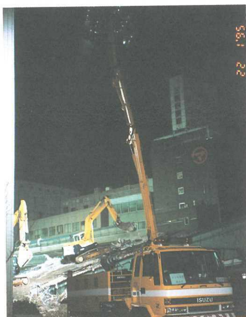
写真-35 照明車の災害現場での活動
