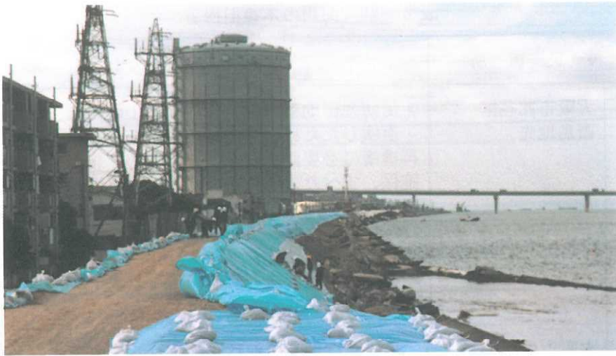
写真-17 淀川・西島地区緊急復旧1次工事
