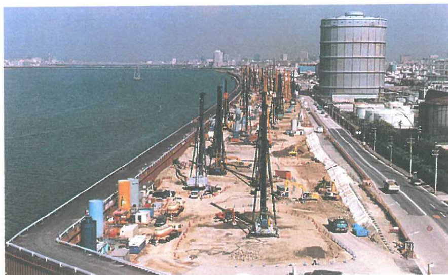
写真-19 淀川・西島地区本復旧工事（深層混合処理工法）
