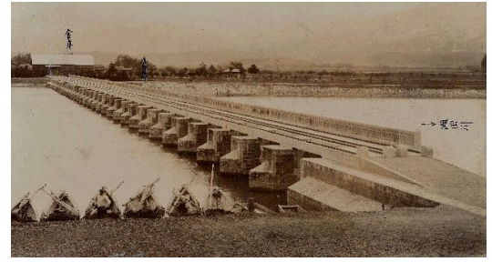
瀬田川を掘削し、平常時の琵琶湖水位を低下し、沿湖の被害を軽減。洪水時の琵琶湖からの流出量を調整。
