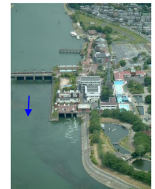
写真 4.3.2-2 瀬田川洗堰のバイパス水路 (平成19年5月)
