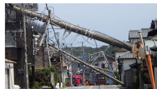
台風により倒壊した電柱
