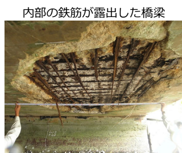
内部の鉄筋が露出した橋梁 早期に措置が必要な施設の例
