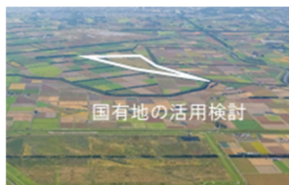
国有地を活用した貯留施設
