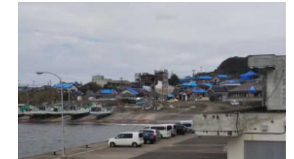
令和元年 房総半島台風 (気象庁職員撮影)
