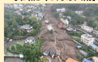
⑪土砂災害の状況 (静岡県熱海市)
