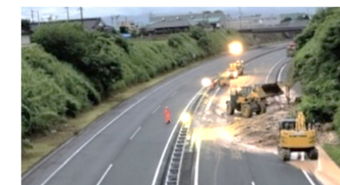
4車線のうち、土砂崩れの被害のない2車線を 活用することで、迅速に通行を確保
