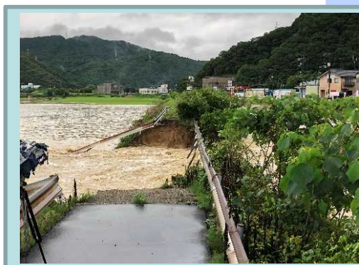
沼田川水系天井川の堤防決壊 (広島県三原市)
