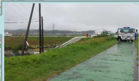
千代川水系清水川 (鳥取県鳥取市) (国土交通省の排水ポンプ車による排水)
