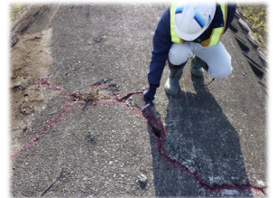
護岸の亀裂の確認状況
