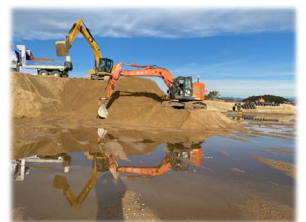
堆積土砂の撤去
