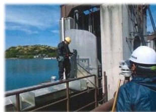
洗堰ゲート設備の点検
