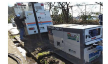
【電源支援班】輪島市 作業状況（29日）
