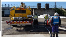
【給水班】金沢市 作業状況（29日）
