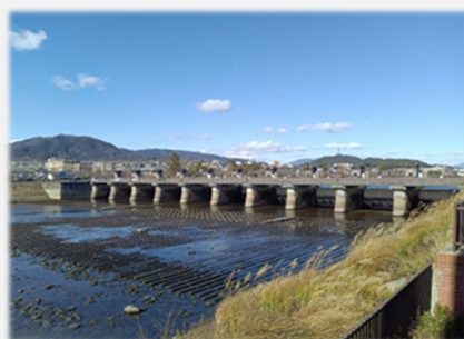
全閉の本堰(左)と必要最小限の水を下流に放流するバイパス水路(右) (令和5年12月22日撮影)
