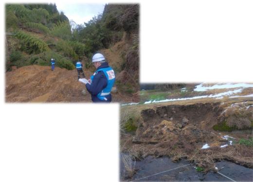
現場状況（砂防班、河川班）
