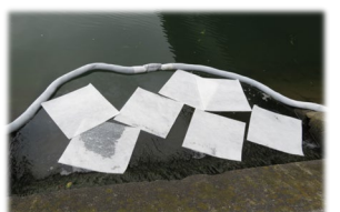
油流出事故対応(オイルフェンス設置)状況
