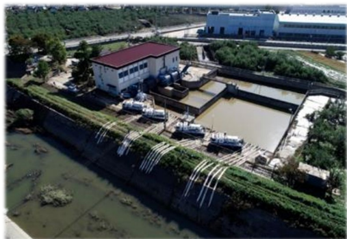
千曲川（長野県）での排水作業（R1. 10）
