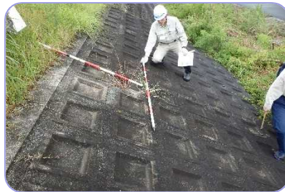
▲護岸点検の様子
