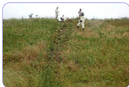
▲堤防点検の様子
