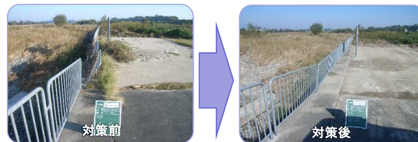
▲安全利用点検の様子
