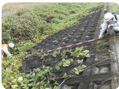
▲護岸点検の様子
