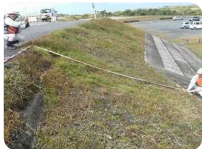
▲堤防点検の様子
