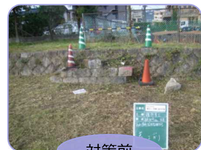
▲高水護岸階段の補修
