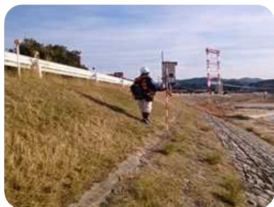
▲堤防点検の様子
