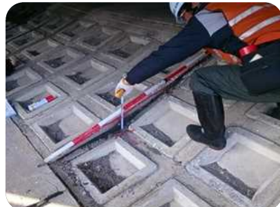
▲護岸点検の様子
