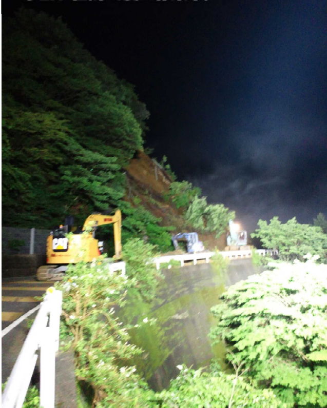
土砂崩れ箇所（復旧作業中）
