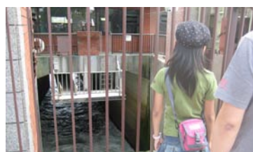
バイパス水路
