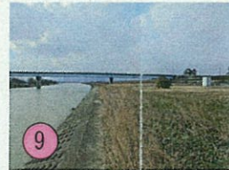
護岸付近(上流側)
