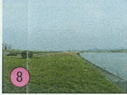
護岸付近(下流側)
