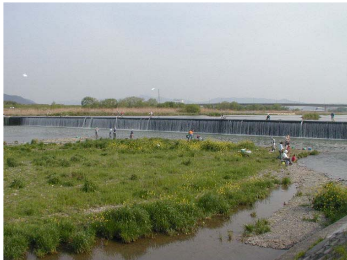
野洲川（落差工付近）
