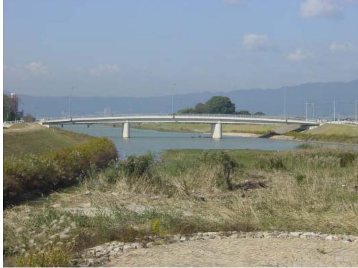
草津川（下流部）
