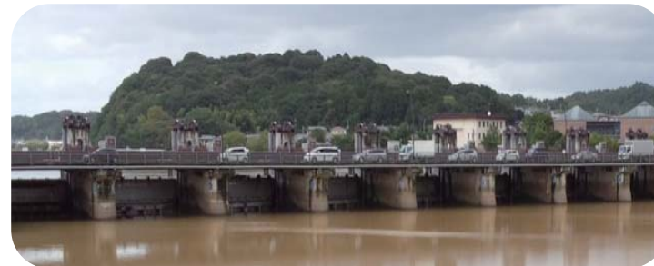
全閉中の瀬田川洗堰(平成25年9月)
