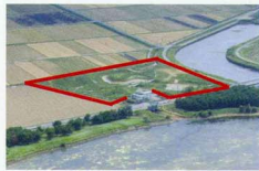
家棟川ピトオプ整備事業
