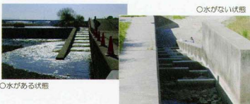
縦断方向の連続性の修復が必要な野洲川落差工
