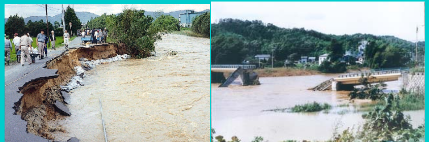
昭和57年台風10号による堤防欠壊 昭和57年台風10号により石居橋流出
