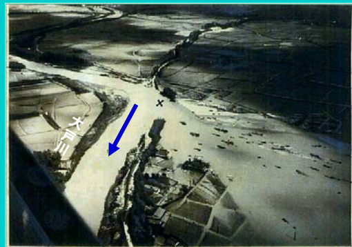
1953年(昭和28年)9月の被害写真
