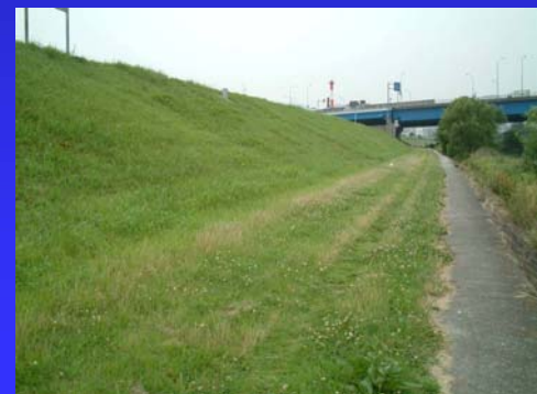
川表に護岸を設置(覆土上に植生が回復)
