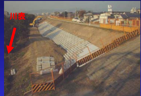
堤防にドレーン工(排水工)を設置
