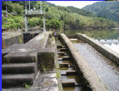
相楽発電所井堰
